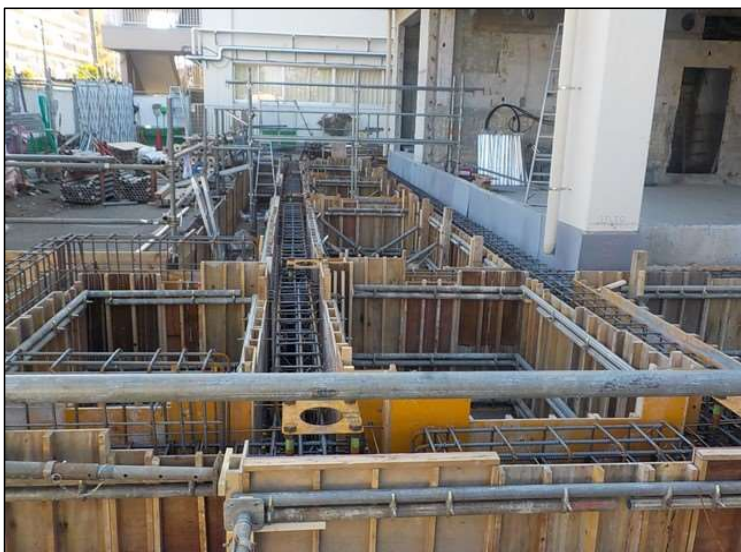
No.3 調布市立石原小学校給食室改修工事 基礎工事 施工状況
