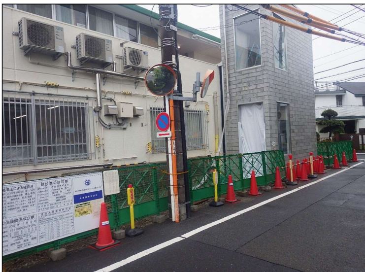
No.6 調布市東部公民館外部エレベーター設置ほか工事 躯体工事 完了
