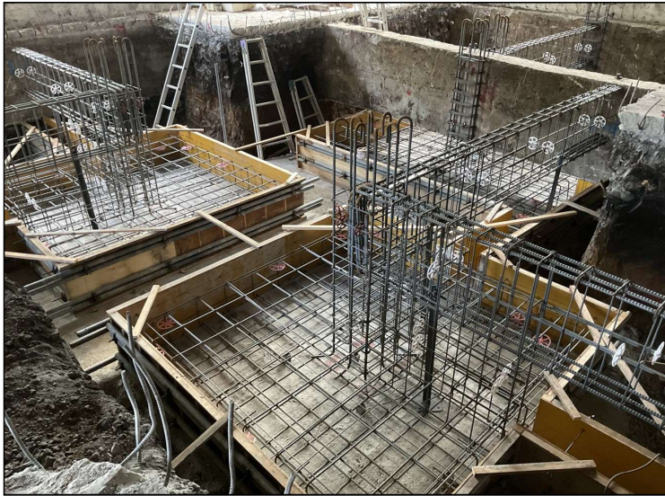
No.1 調布市立深大寺小学校給食室改修工事 基礎工事 施工状況
