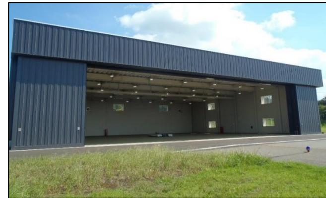
大島空港格納庫
