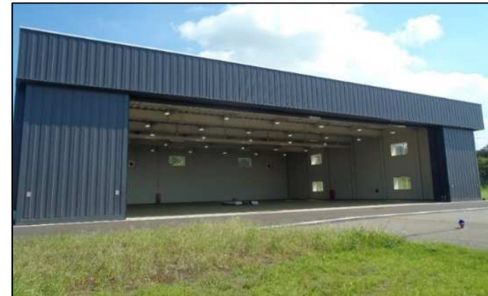
大島空港格納庫
