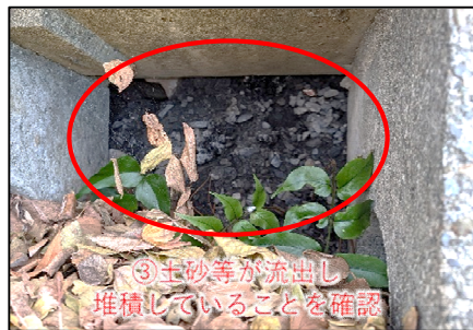
護岸の状況 (護岸の緑化ブロック側より)
