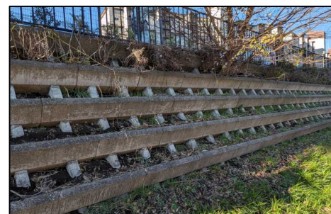
護岸の状況 (護岸の緑化ブロック側より)
