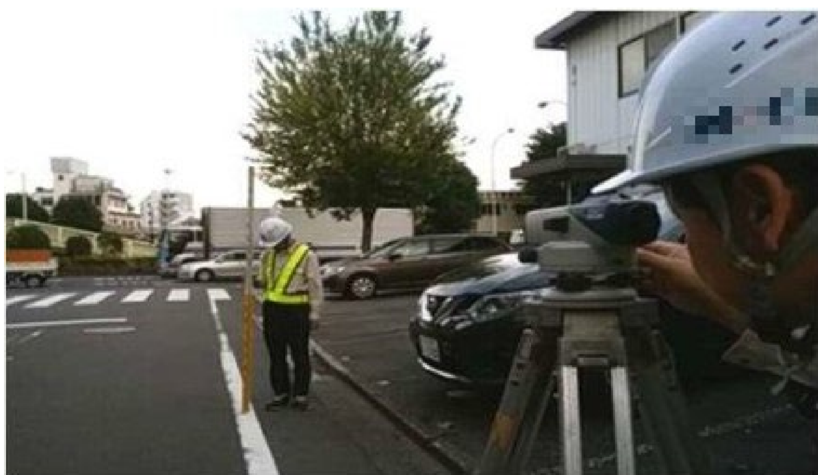
地上部での作業(イメージ)
