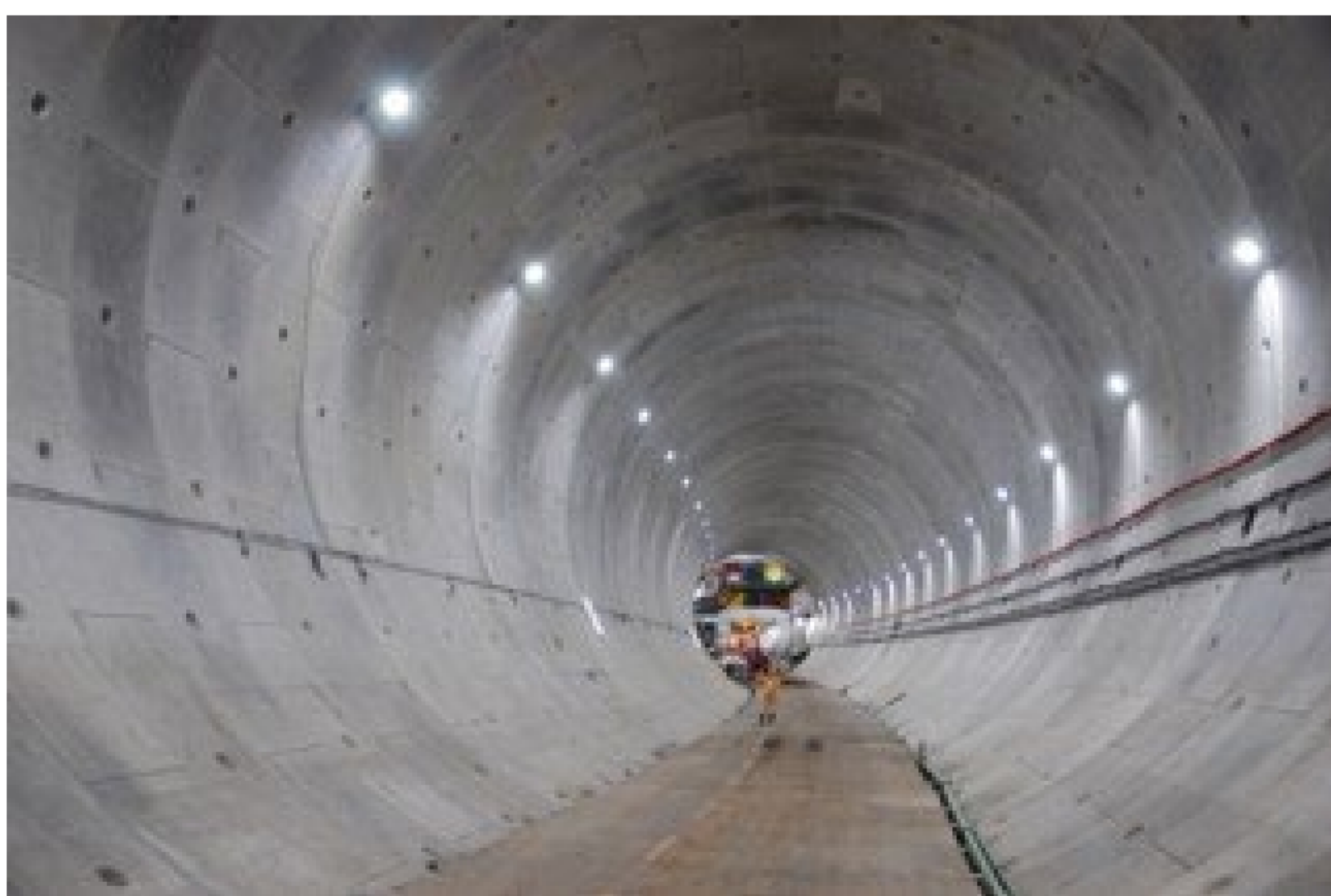
トンネル内部の写真(イメージ)
