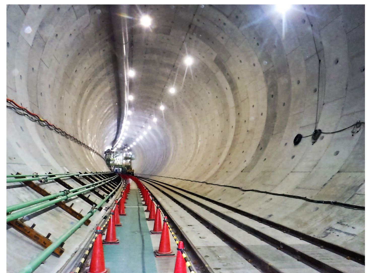
トンネル内部の写真(イメージ)
