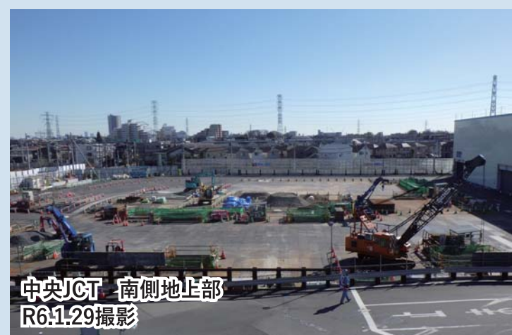
設備用の地下構造物を施工中
