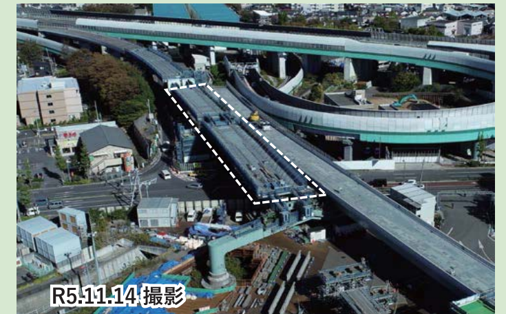
目白通りを越えるCランプ橋を架設
