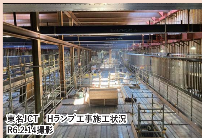
ランプ部となる地下構造物を施工中
