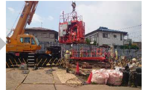
地盤補修マシンの据付
