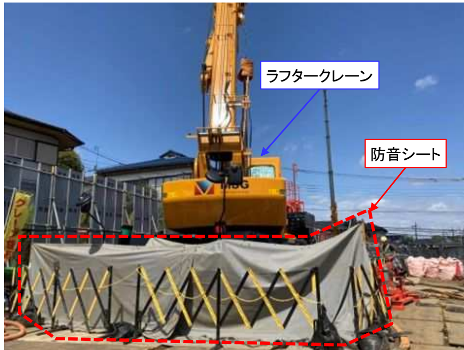
ラフタークレーンへの防音シート
