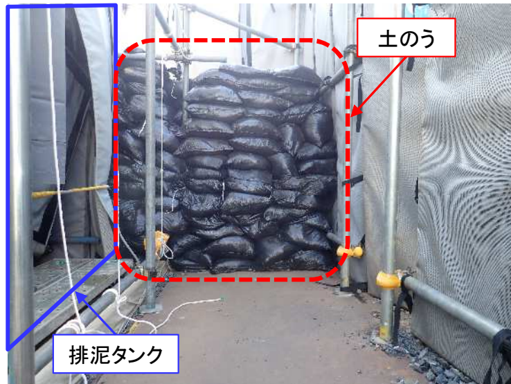
排泥タンク周辺への土のう
