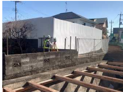
変状調査（測量）
