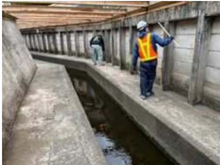
変状調査（点検）
