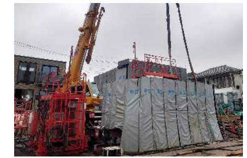
削孔・地盤改良体造成(近景)
