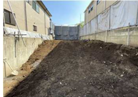
家屋解体完了
