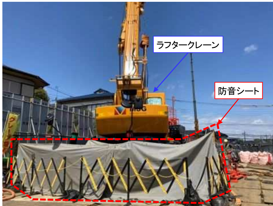
ラフタークレーンへの防音シート
