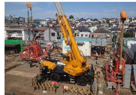
削孔・地盤改良体造成(全景)
