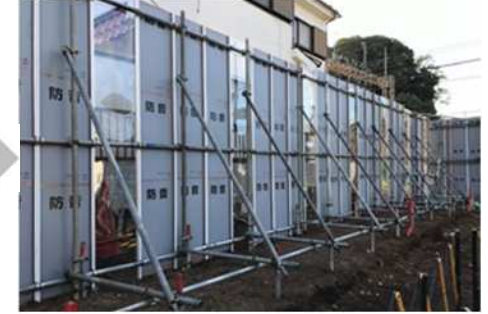
仮囲いの設置
