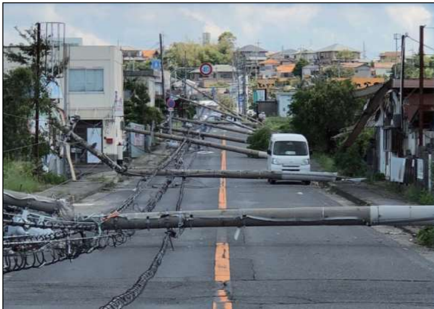
平成30年台風第21号による電柱倒壊(大阪府泉南市) 出典:国土交通省
