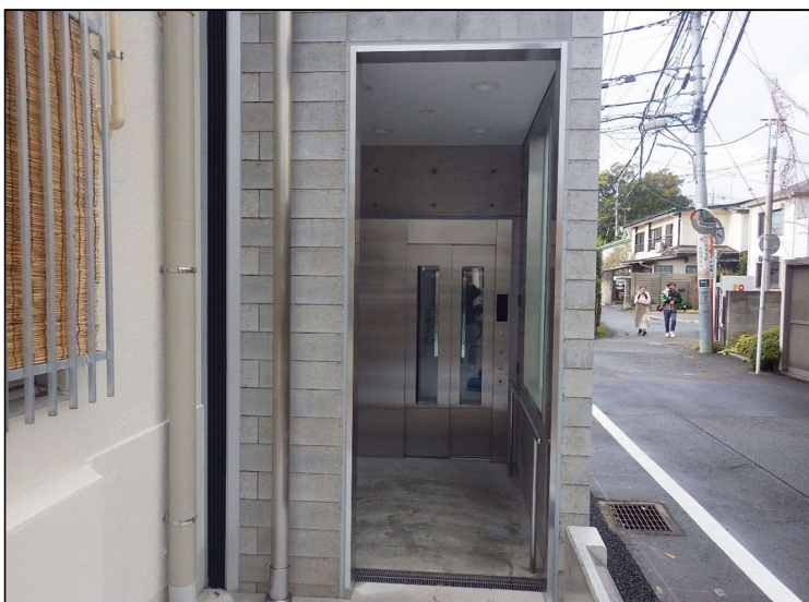
No.6 調布市東部公民館外部エレベーター設置ほか工事 エレベーター 設置完了
