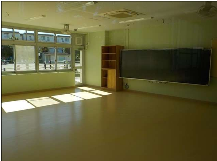
No.5 調布市立多摩川小学校普通教室整備工事 内部改修 施工状況
