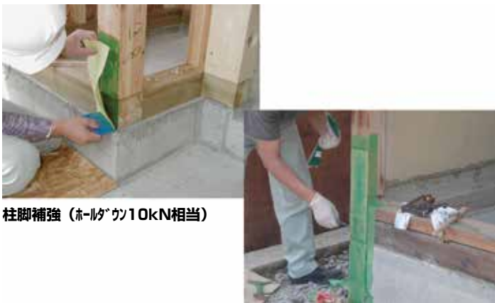
柱脚補強 (ホルダウ15kN相当)
