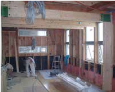
間仕切部の耐震補強
