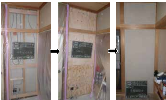
合板受材施工
