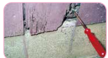
土台の腐朽度合いを調査
