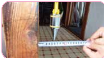
下げ振りで柱の傾きを調査
