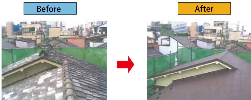
屋根の軽量化を行った事例(写真提供:飯田工務店)
