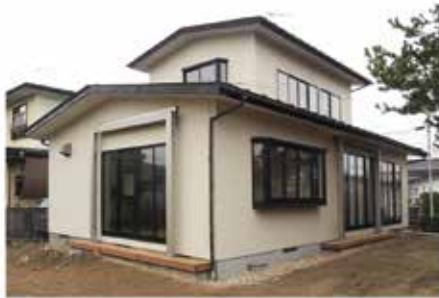
フレームプラス施工事例
