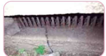
基礎のひび割れを調査
