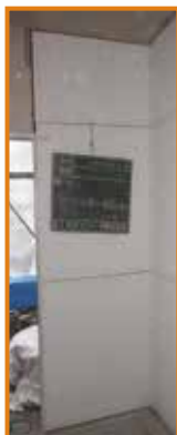
③パネルの施工
