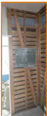
①既存壁の撤去
