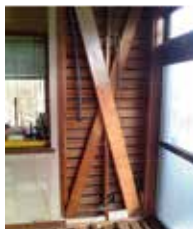
食堂内既存壁補強状況
