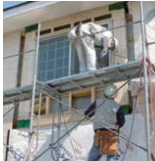
2階の開口部補強
