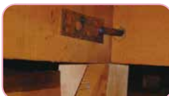
小屋裏から筋交いの取付け状況や 羽子板ボルトの有無を調査
