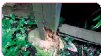
柱脚の腐朽を調査
