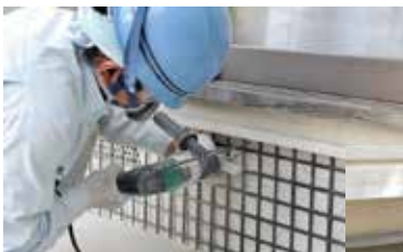
FRPグリッド設置
