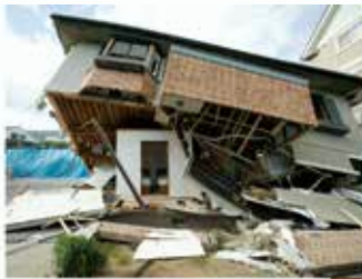
倒壊実験写真
