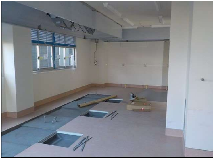
No.1 調布市立深大寺小学校給食室改修工事 調理室内 施工状況
