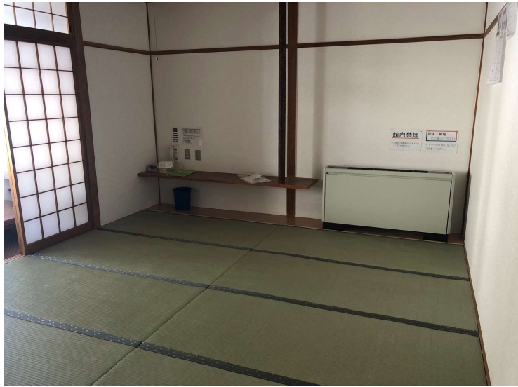
No.4 調布市八ヶ岳少年の家空調設備ほか改修工事 客室内 室内機設置状況
