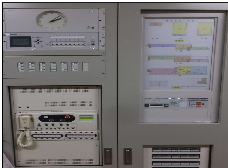
No.6 調布市八ヶ岳少年自然の家防災設備改修工事 防災設備 更新完了
