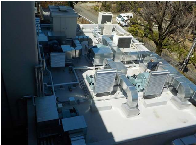
No.2 調布市立深大寺小学校給食室改修工事 給食棟屋上 工事完了 厨房機器 設置完了
