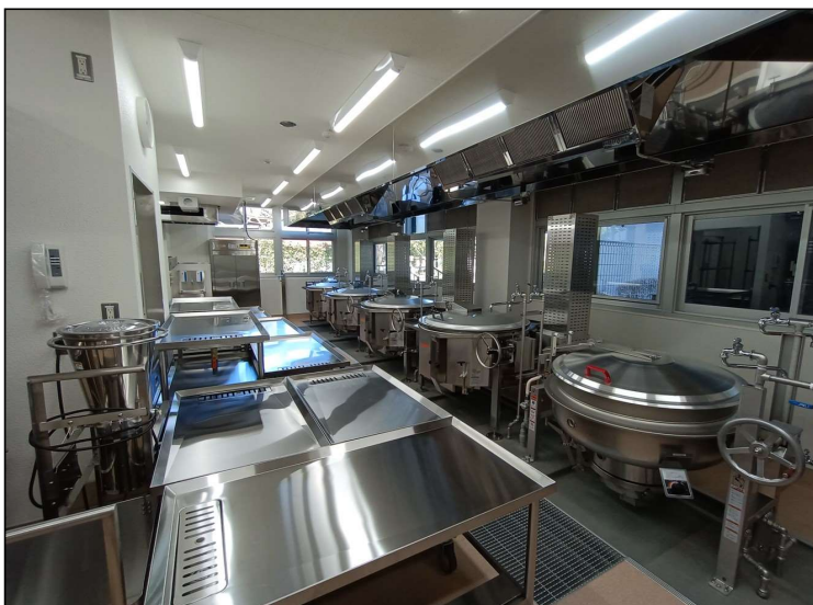
No.3 調布市立深大寺小学校給食室改修工事 調理室内 工事完了
