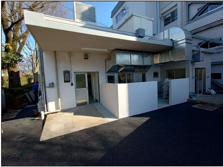
No.1 調布市立深大寺小学校給食室改修工事 給食棟外部(西側) 工事完了
