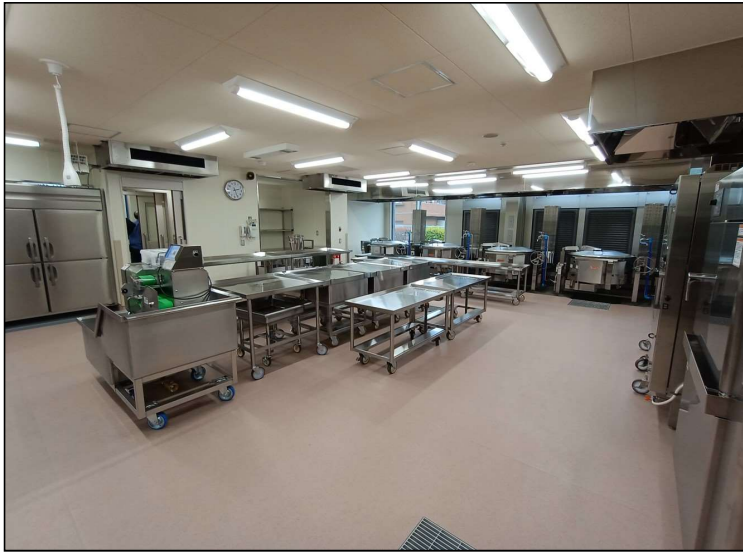
No.4 調布市立石原小学校給食室改修工事 調理室内 工事完了
