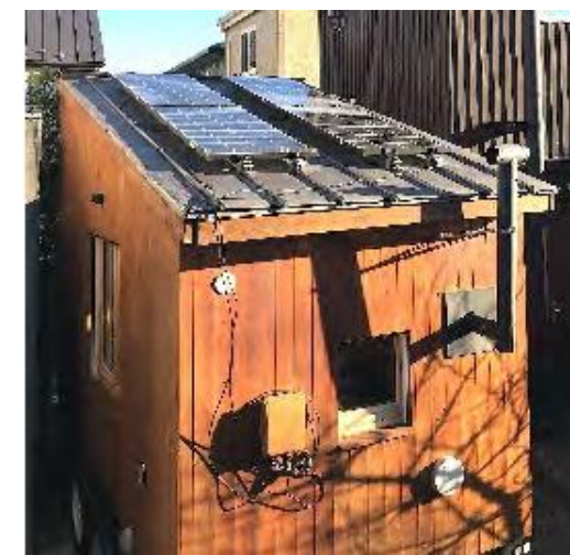
太陽光発電と蓄電池で電力を自給する 木造のトレーラーハウス「移動式えねこや」の体験 （一般社団法人えねこやブース）
