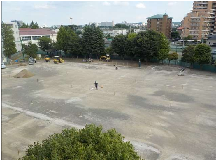
No.1 調布市立杉森小学校校庭整備工事 表層土 撤去状況
