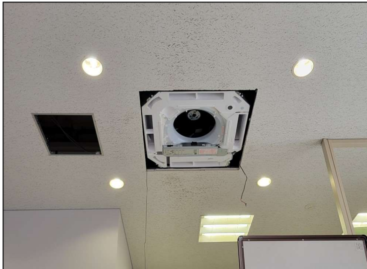
No.2 調布市青少年交流館空調設備ほか改修工事 空調機器 施工状況
