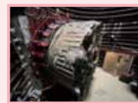
掘削機械貫通の瞬間
