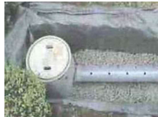
浸透トレンチ
