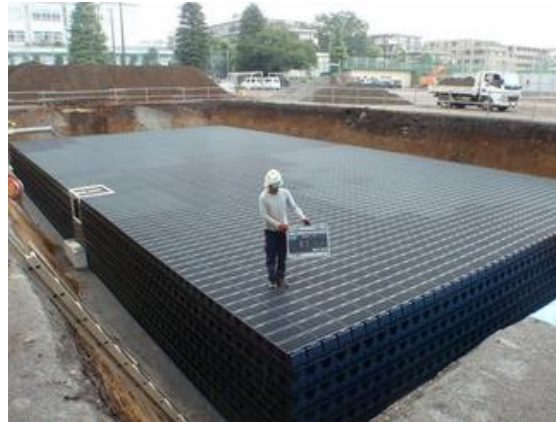
市立第一中学校校庭への施設設置の様子
