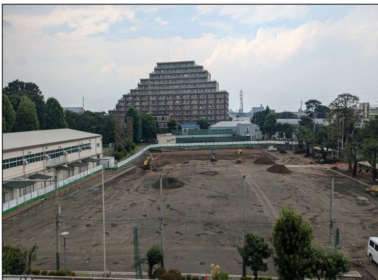
No.3 調布市立神代中学校校庭整備工事 表層土 撤去状況
