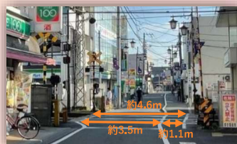
現在の踏切の幅員:約4.6m (車道:約3.5m, 歩道:約1.1m)
