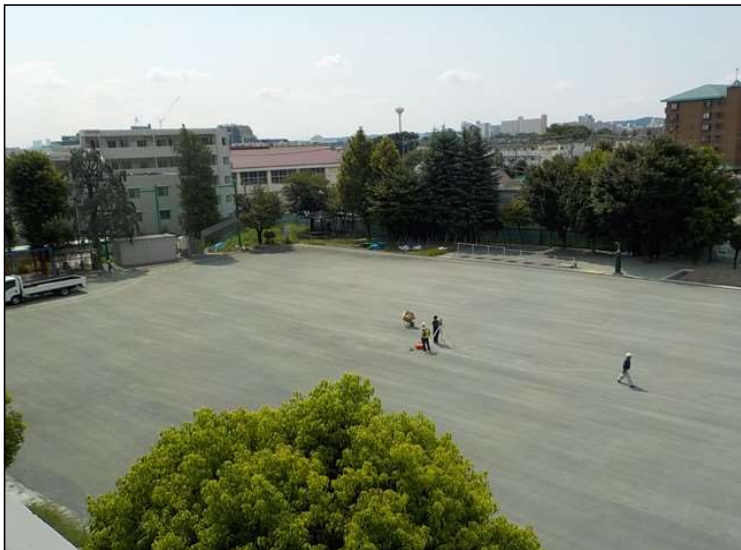
No.2 調布市立杉森小学校校庭整備工事 校庭内 施工状況
