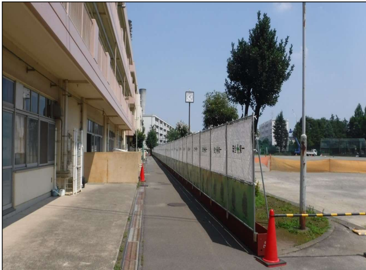
No.4 調布市立第三中学校校庭整備工事 仮囲い 設置状況
