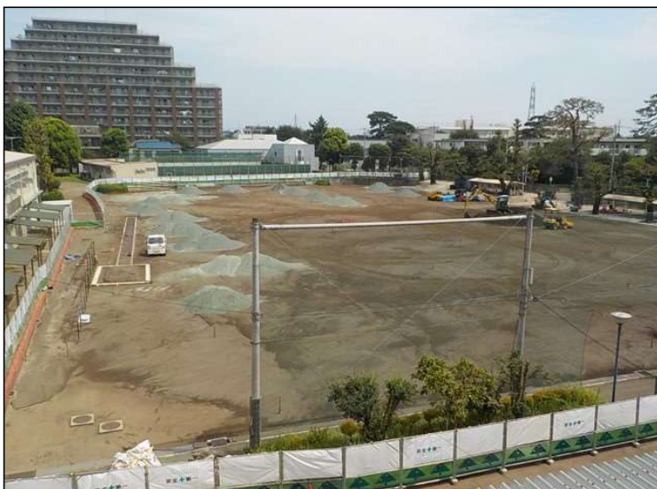
No.3 調布市立神代中学校校庭整備工事 校庭内 施工状況
