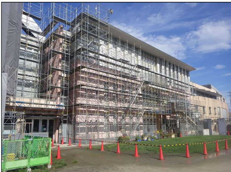
No.6 調布市立調和小学校校舎外壁及び屋上防水改修工事 仮設足場 設置状況
