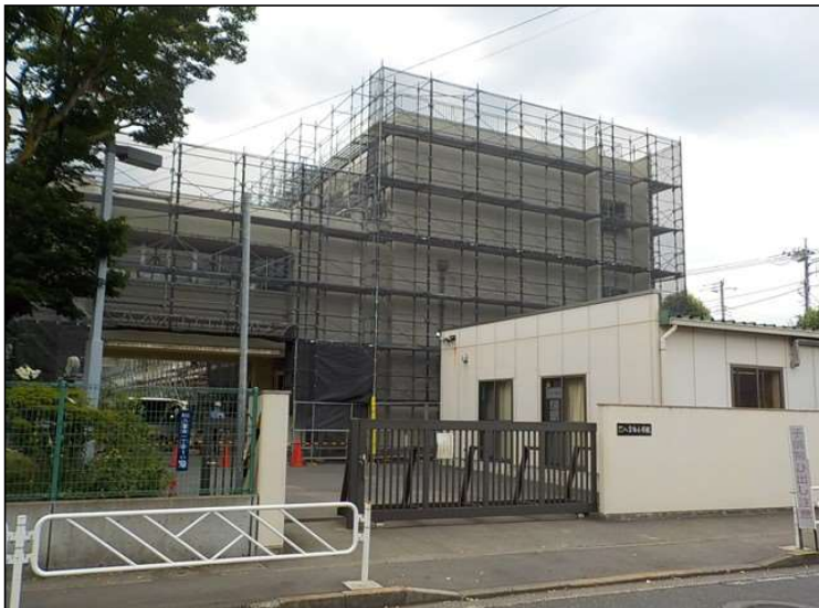
No.5 調布市立八雲台小学校校舎外壁及び屋上防水改修工事 仮設足場 設置状況
