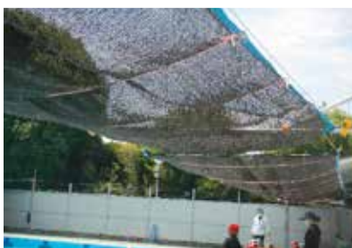
プールに大きな日よけを設置いただきました
