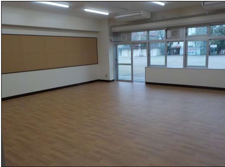
No.1 調布市立第一小学校普通教室整備工事 教室内部 施工完了
