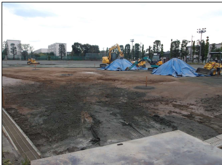
No.3 調布市立第三中学校校庭整備工事 校庭内 施工状況
