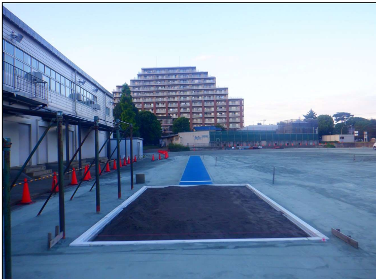
No.2 調布市立神代中学校校庭整備工事 校庭内 施工状況
