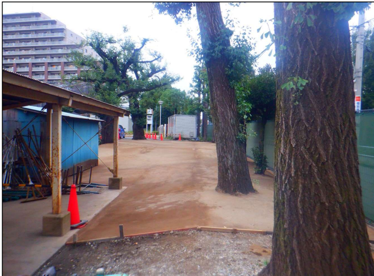
No.1 調布市立神代中学校校庭整備工事 外構部 施工状況
