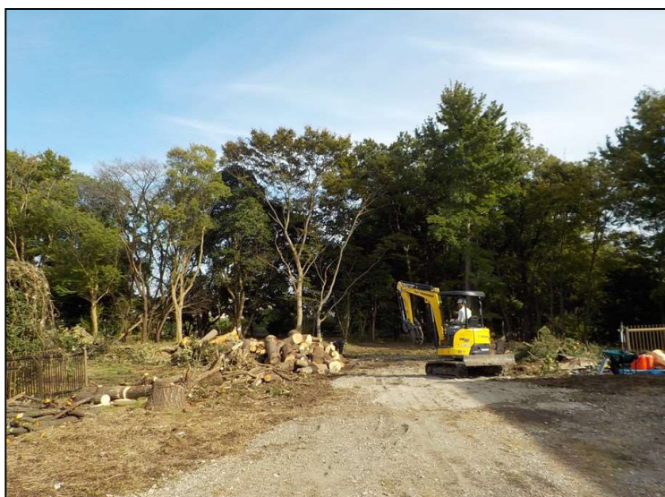
No.6 調布市国史跡下布田遺跡整備工事(第1期) 既存樹木 伐採抜根状況
