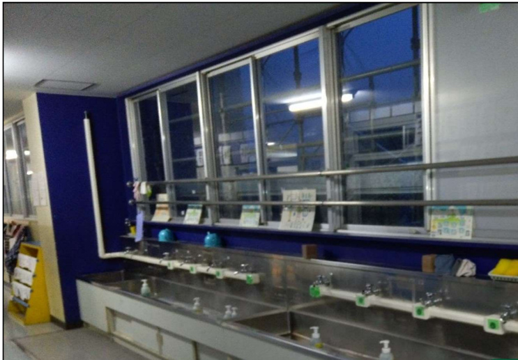
No.4 調布市立八雲台小学校給水管改修工事 手洗い場 施工状況
