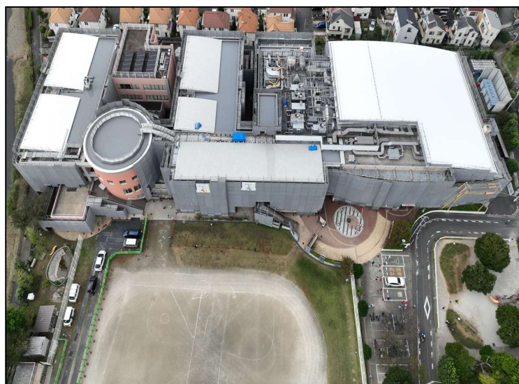
No.3 調布市立調和小学校校舎外壁及び屋上防水改修工事 屋上防水改修 施工状況
