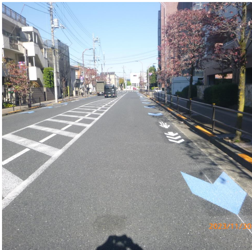
市道C38号線自転車走行環境整備工事 (令和5年度実施)
