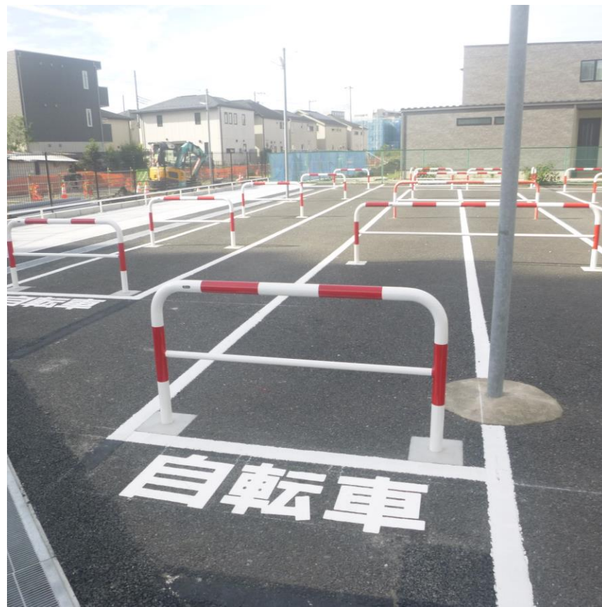
国領西自転車等駐車場改修工事 (令和6年度実施)
