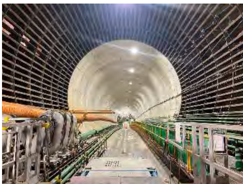
シールドマシン後方の状況 (令和6年11月25日)
