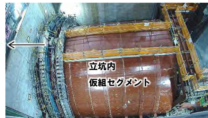
発進立坑部の状況 (令和6年11月20日)
