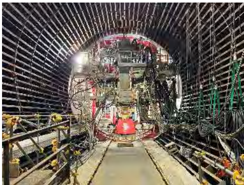
シールドマシン後方の状況 (令和6年11月20日)
