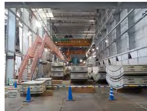
セグメントストックヤードの状況 (令和6年10月31日)
