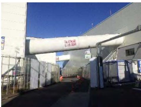
ベルトコンベアの状況 (令和6年11月29日)
