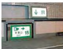
路面下への非常口(路面から)
