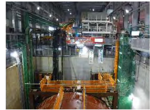
防音ハウス内の状況 (令和6年11月29日)
