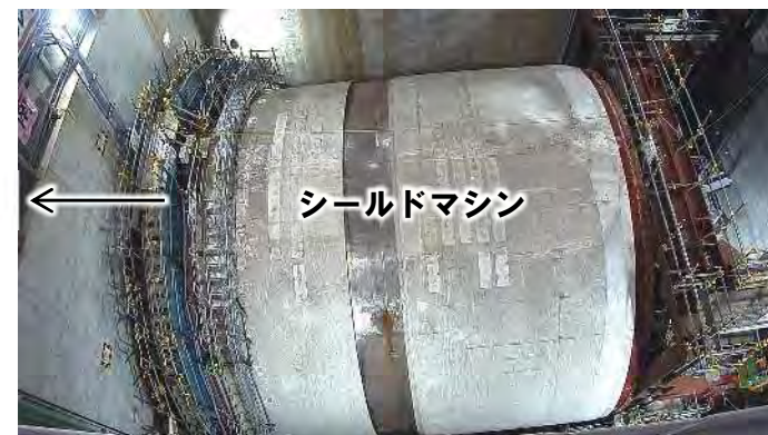
発進立坑部の状況 (令和6年9月18日)
