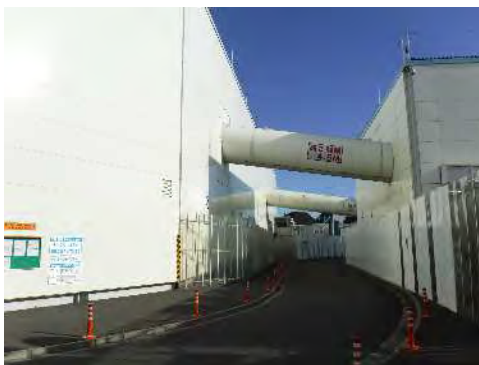
ベルトコンベアの状況 (令和6年11月29日)
