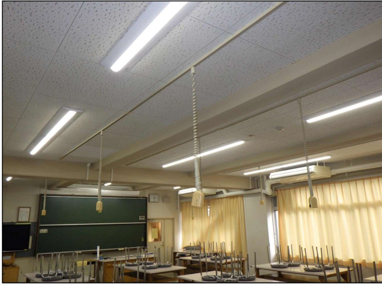
No.4 調布市立第七中学校校舎LED化改修工事 被服室 LED化完了
