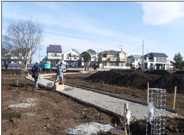
No.5 調布市国史跡下布田遺跡整備工事(第1期) 園路路盤 施工状況
