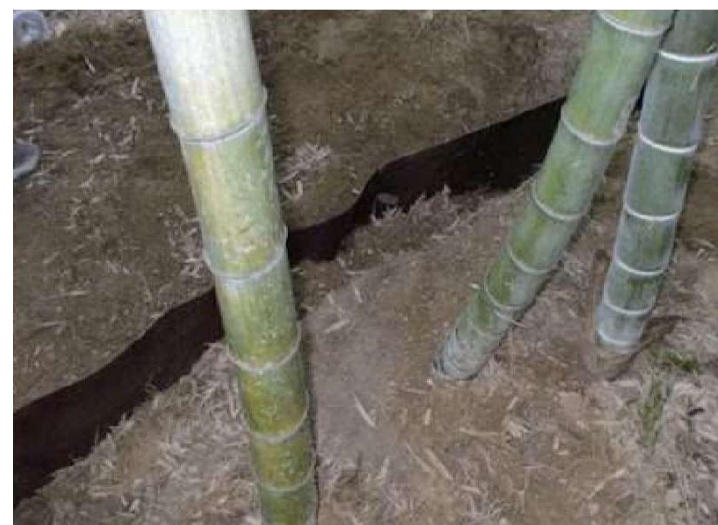
防根シート施工例 http://hodumi.co.jp/jworks/sp/item/?id=3590
