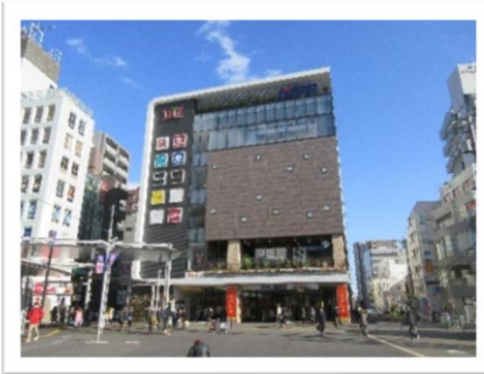
京王線連続立体交差事業（H16～H26年度）により創出されたトリエ京王調布A館
