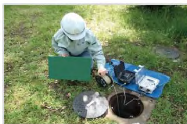
地下水位の観測状況
