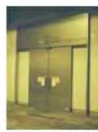
首都高速中央環状新宿線の例
