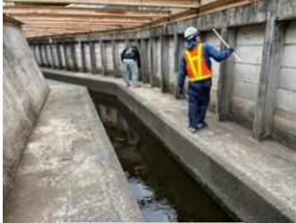
変状調査(点検)
