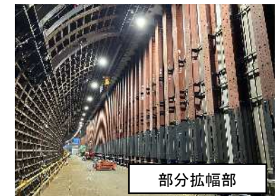
東名JCT地中拡幅(南行)の現地の状況
