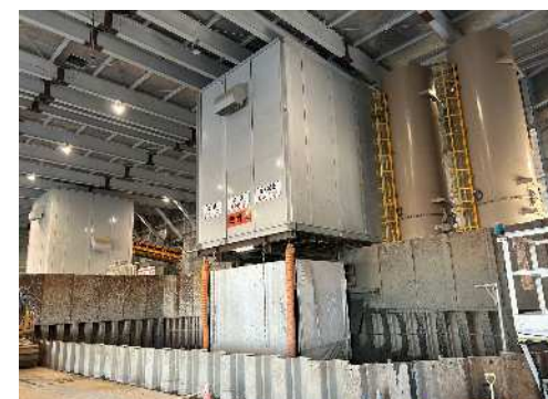
土砂ピットヤード内部の状況 (令和7年11月27日)
