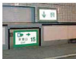
路面下への非常口(路面から)
