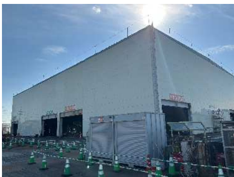
土砂ピットヤードの状況 (令和7年11月27日)
