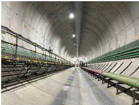
坑内の状況 (令和7年11月27日)
