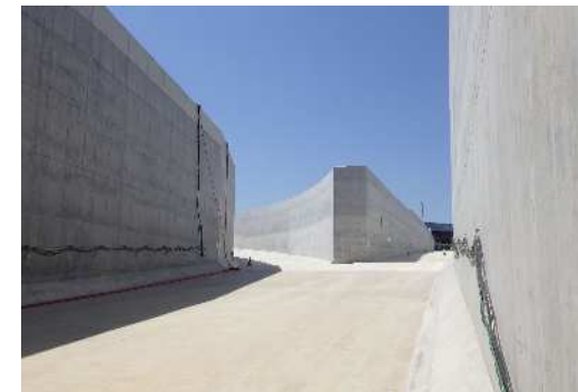
中央JCT北側開削トンネル施工状況 (令和5年5月16日)
