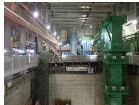
防音ハウス内の状況 (令和7年11月27日)
