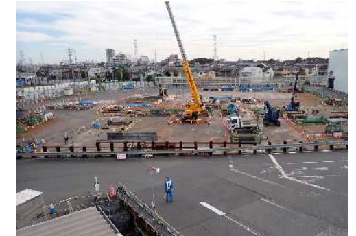
中央JCT南側開削トンネル施工状況(地上部) (令和7年11月12日)
