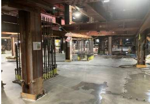
中央JCT南側換気所施工状況 (令和7年11月26日)
