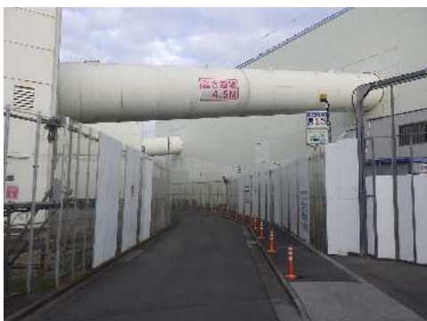
ベルトコンベヤーの状況 (令和7年11月27日)
