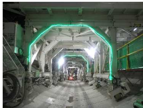
シールドマシン後方の状況 (令和7年11月27日)
