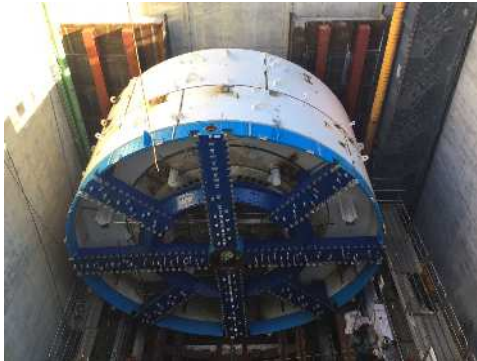
シールドマシンの組立状況 (平成30年12月19日)
