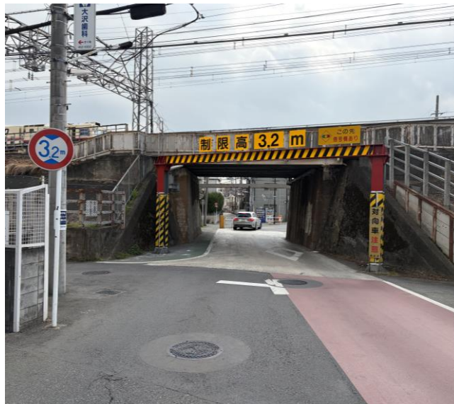
調布3・4・9号線の鉄道交差点(清水架道橋)
