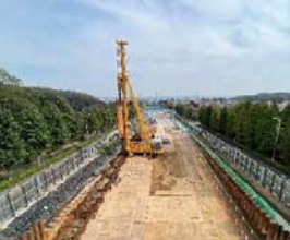
ICT建機による地盤改良工
