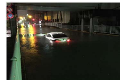
八高線アンダーパス（八王子市）
