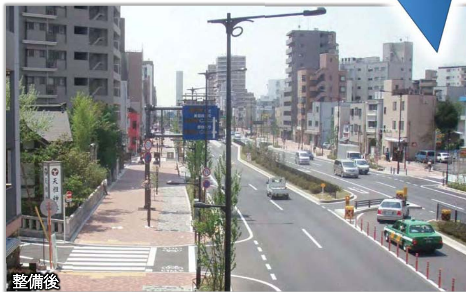
左：宮下歩道橋 右：富士見台歩道橋 出典：第27回全国街路事業コンクール
