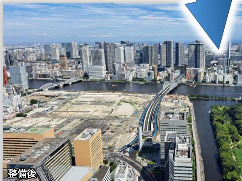
写真は築地・新橋間
