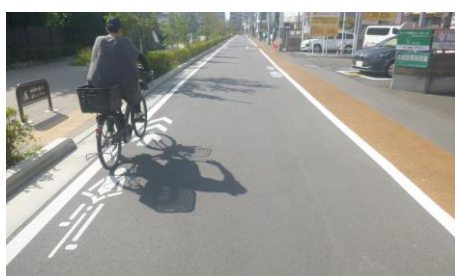
図 5-37 市内の車道混在（自転車ナビマーク）の整備事例（市道 S104 号線）
