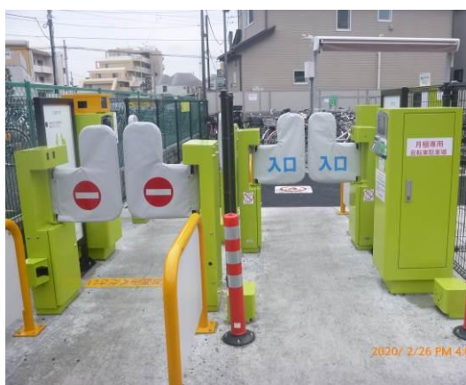
ゲート式システム つつじヶ丘駅南口西自転車駐車場
