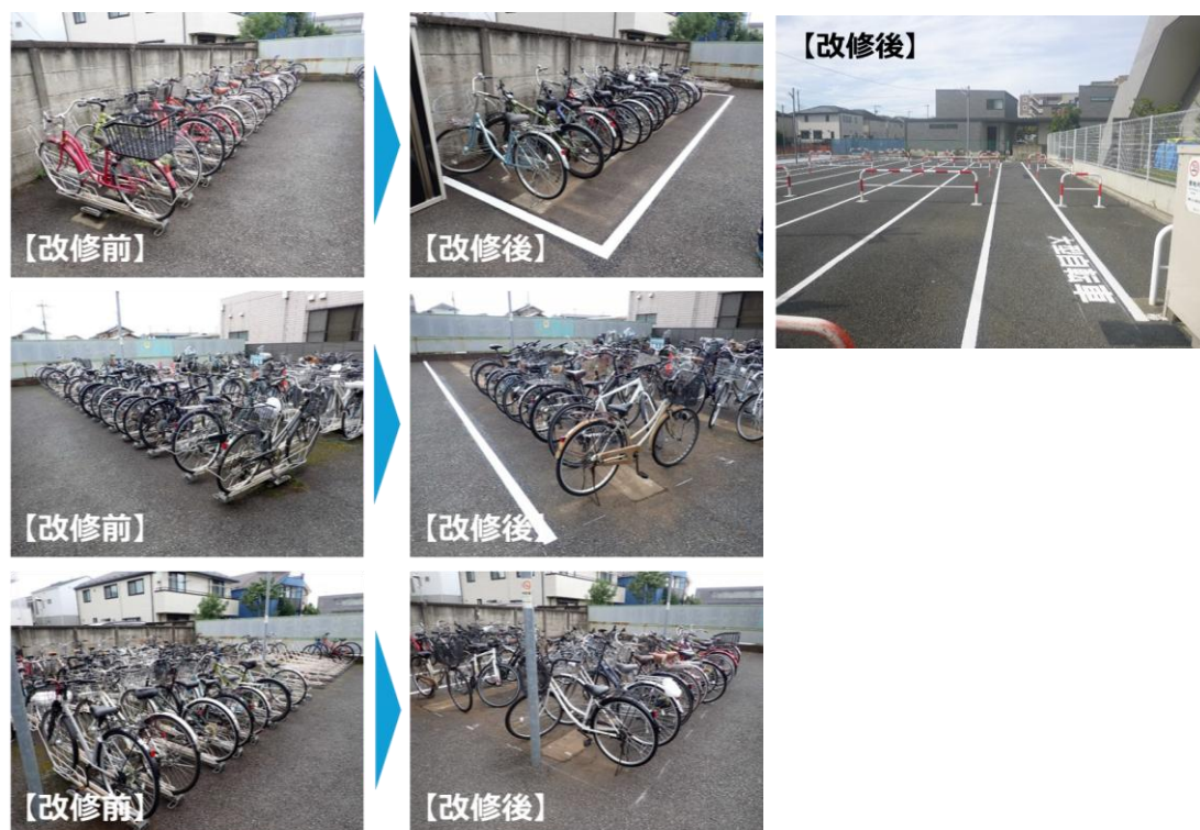
図 6-12 ラック式から平置き式への改修の例
