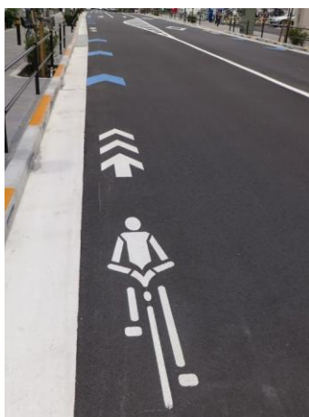
図 5-32 市内の車道混在の整備事例（西調布駅北側・市道C16号線）
