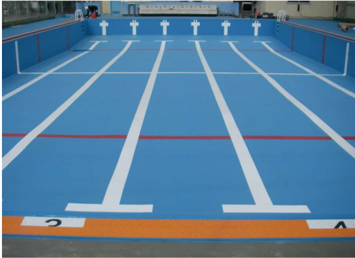
No.4 調布市立第一小学校プール改修工事 水槽更新 施工完了
