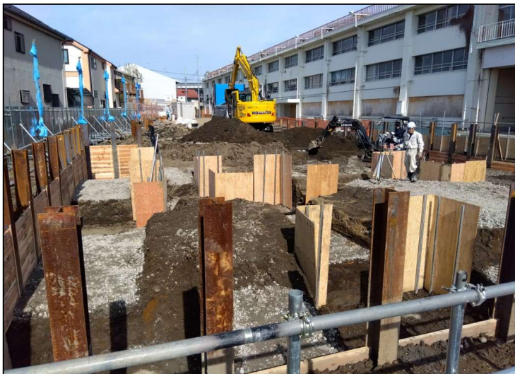
No.6 調布市立図書館宮の下分館改築工事 山留 施工状況
