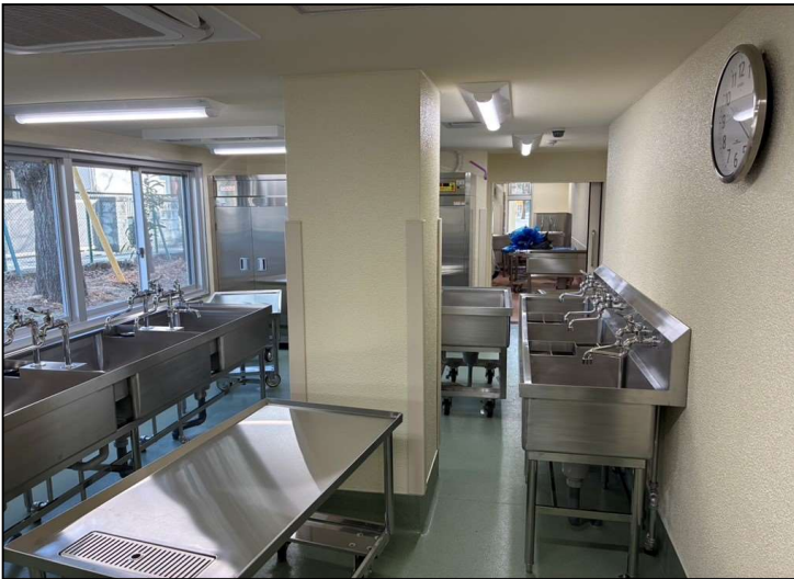
No.2 調布市立富士見台小学校給食室改修工事 厨房機器 設置状況
