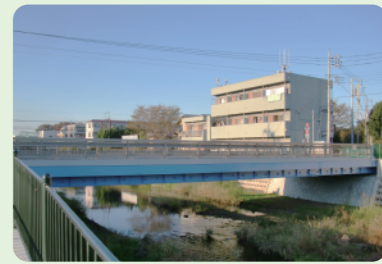
14 H30年度完成 車橋
