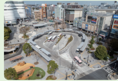
7 R7年度完成 調布駅前広場
