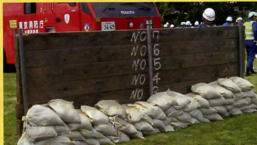
木板を積み重ね、堤防側に土のうを積んでいく
