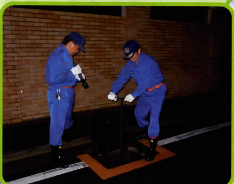
消火栓の点検
