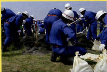
土のう袋に土を入れ、土のうを作成していく
