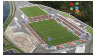
岩手県・釜石市 釜石鶏住居復興スタジアム(仮称)
