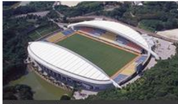
福岡県・福岡市 東平尾公園博多の森球技場
