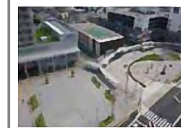
I 駅舎・駅前広場の整備
