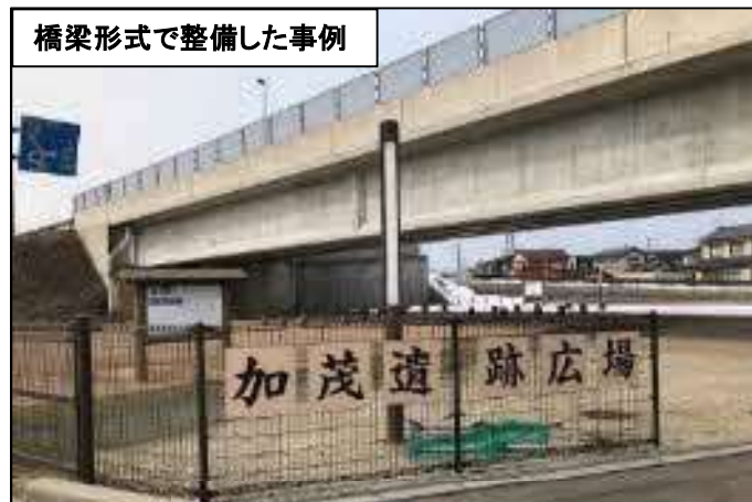
整備事例（石川県加茂遺跡） 史跡の上部に橋梁を建設した事例
