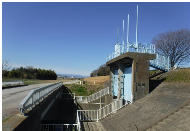
調布排水樋管
