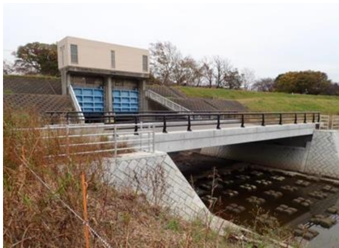
六郷排水樋管
