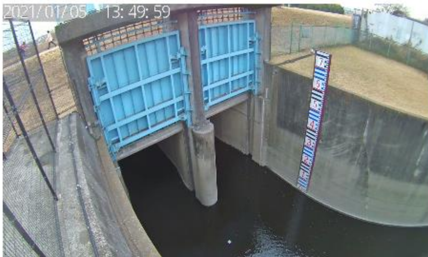
河川最新画像：[調布排水樋管]調布幹線側
