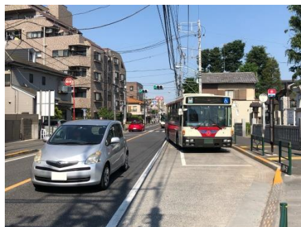
図 3-9 バス停留所（バスベイ）の設置例
